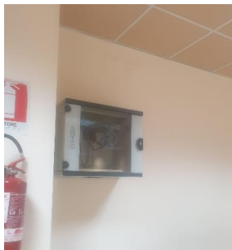
Armadio Corridoio Padiglione Nuovo
